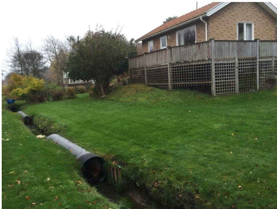
Fig.9 Bäck som passerar fastigheterna Morik 3:16 och 3:17. Vattenflödet från berget vid väg 721 passerar här och vidare ner i Stockevik.
