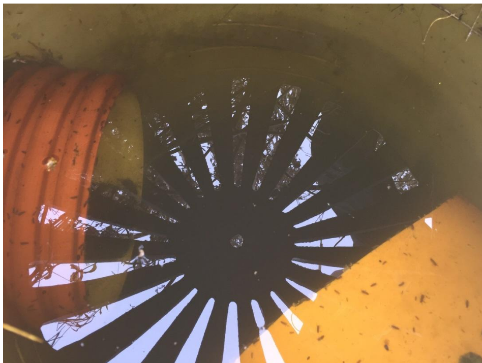
Fig 13. Dämda ledningar i kupolbrunn vid Goviksbäcken
