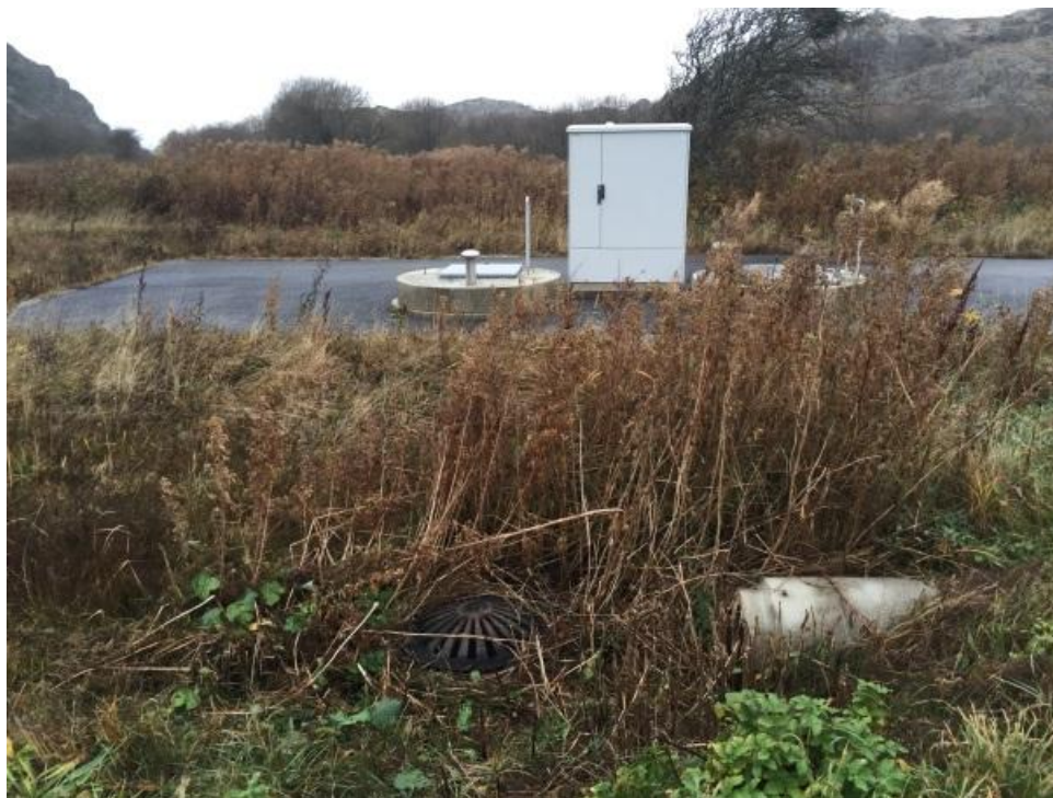
Fig 12. Kupolbrunn framför ny pumpstation intill Goviksbäcken
