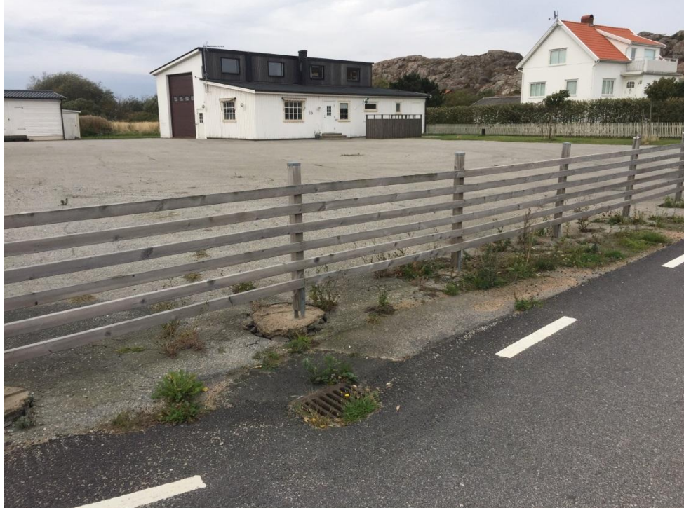
Fig 5. Rännstensbrunn vid fastighet 1:98
